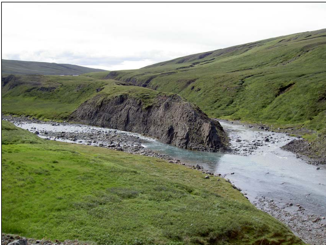
Mynd 11. Ármót Þuriðardalsár og Glúmsstaðadalsár. Ný veglína Austurleiðar vestan við Glúmsstaðadalsá, til hægri á mynd (Ljósmynd: Birgir Guðmundsson, 2006)
